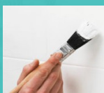
REPAROS NA CASA
